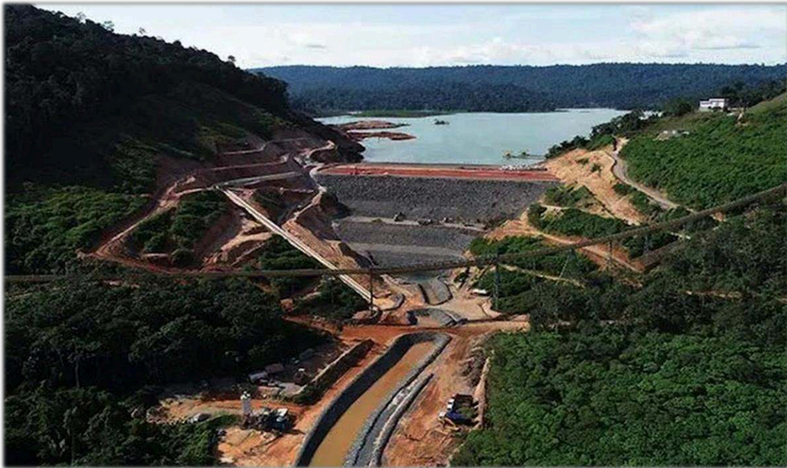
Figura 7 - Barragem Mirim da Mina Salobo, da Vale S.A..
