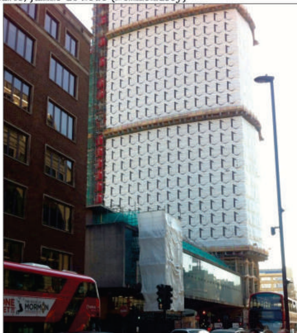
Obra em Londres, maio de 2015 (Tottenham Court Road)
