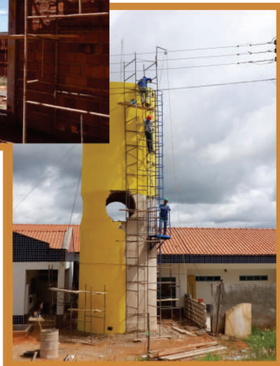
Exemplos de situações de risco de queda de trabalhadores e projeção de materiais em obras de todo o país. Os casos, frequentemente apurados nas obras do país, apresentam andaimes e instalações completamente inseguros e inexistência de proteções coletivas nos locais de trabalho. Fotos registradas por Auditores Fiscais do Trabalho em diferentes estados e regiões do Brasil entre 2012 e 2015
