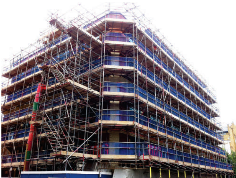
Obra em Londres, junho de 2015 (Bermondsey)
