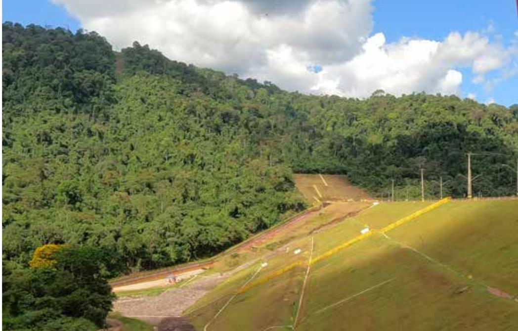
A ZAS de Pera Jusante é cortada por uma linha de trem, além da existência de várias estruturas na área de risco. A solução encontrada pela Vale no acordo firmado com o MPT, na 2ª Vara do Trabalho de Parauapebas, foi a construção de uma barreira defletora que altera a ZAS.
